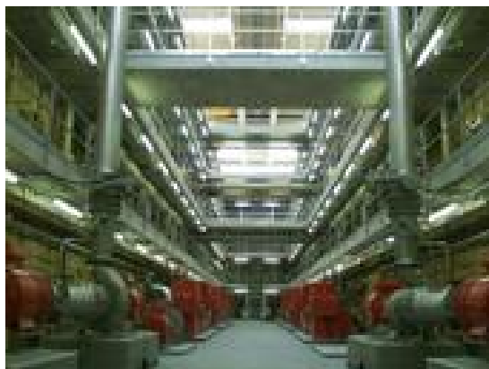
Seewasserwerk von Innen
