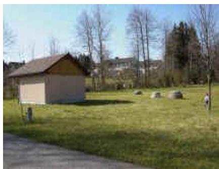
Grundwasserfassung "Säge" (heute)
